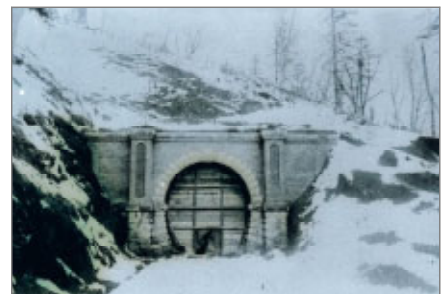
（竣工時の新内隧道南口抗門）
